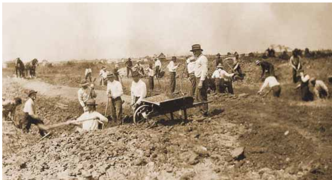
2. Prace przy budowie kościoła, 1917 r.
