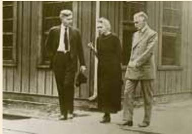
Visite à l'usine de radium de Pittsburgh.
